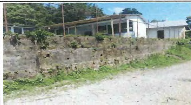
Foto1: Reparacion muro de contencion, orilla de calle.
