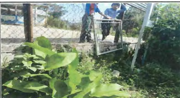
Foto 3: Reparacion muro perimetral de block, colindante propiedad privada.
