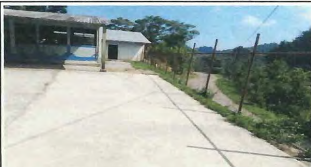
Foto 2: Reparacion muro perimetral de block Orilla de calle.
