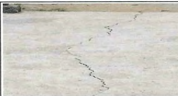
Foto 5: Mejoramiento de piso en la cocina.
