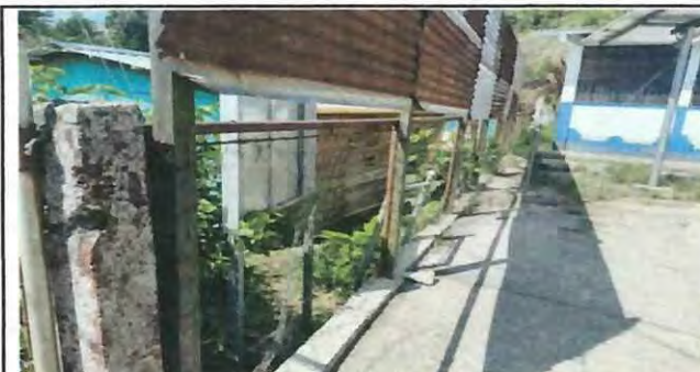
Foto 4: Reparacion muro perimetral de block
